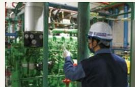
1時間あたり6mm以上の雨が降る予報が出た場合や雨水ポンプの運転が開始した場合には、中央監視室から動員が発令されます。指示された大島ポンプ場へ向かい、まずは、雨水を排水しているポンプに振動などの異常が発生していないか、正常に雨水を汲み上げ排水しているかを確認。動員時も複数人で臨む体制をとり、動作確認・連絡調整・緊急対応が滞りなく行えるようにしています。
