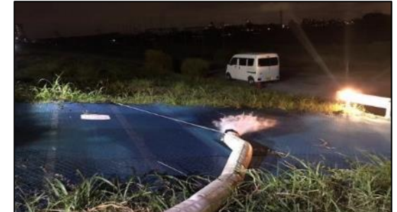
樋管先管きょ排水状況
