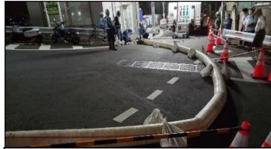
内陸側排水状況
