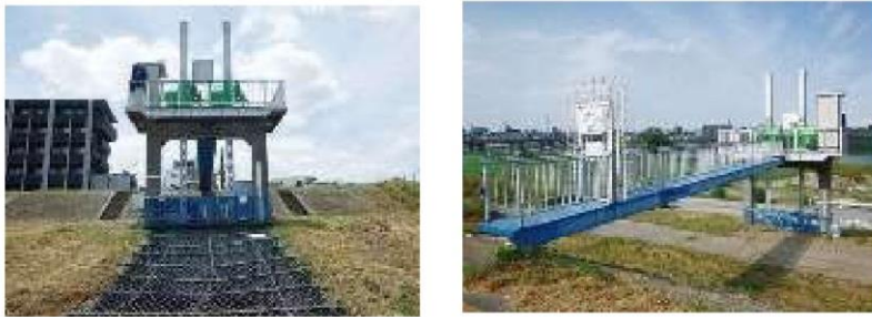
排水樋管ゲートの改良
