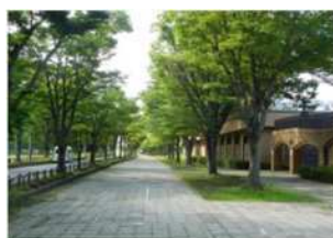
麻生水処理センター
