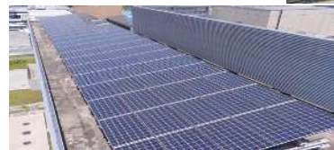
入江崎水処理センター
