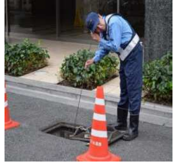
漏水調査の様子
