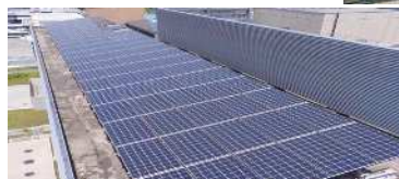
入江崎水処理センター
