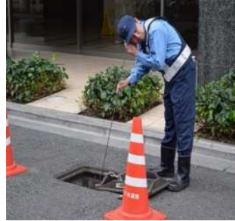
漏水調査の様子
