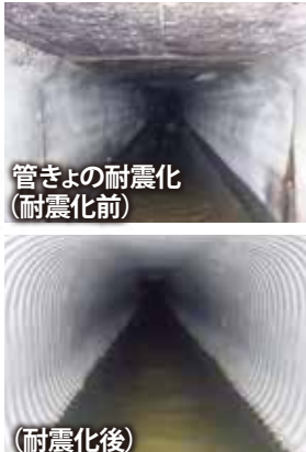
管きよの耐震化(耐震化前)
