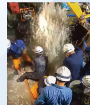
管を修理している様子
