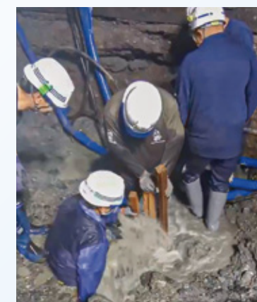
漏水を止める様子
