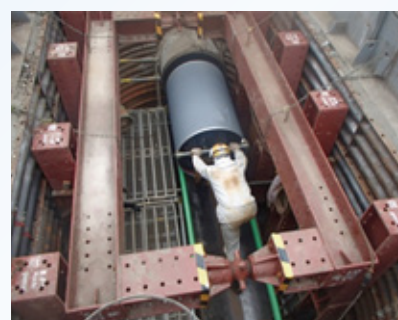
大きな水道管(直径40cm以上)の工事現場の様子
