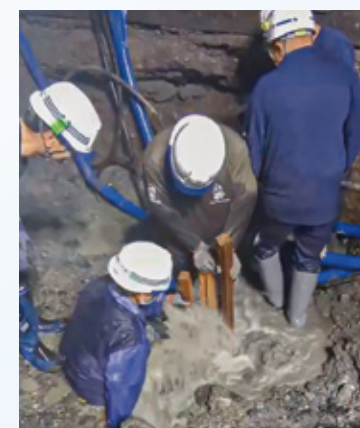
漏水を止める様子
