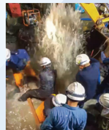
管を修理している様子
