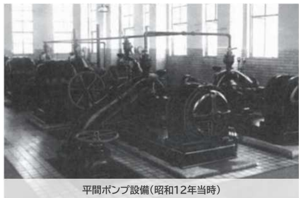
平間浄水場(昭和12年当時)
