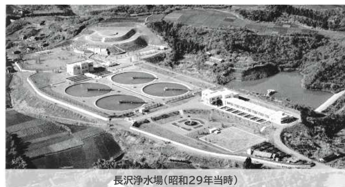
長沢浄水場(昭和29年当時)
