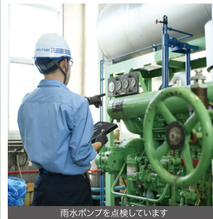
雨水ポンプを点検しています
