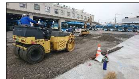
営業所車庫の路面補修
