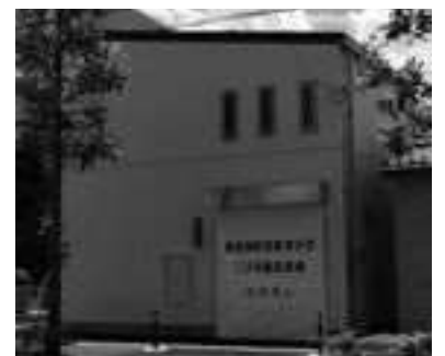
高津消防団高津分団 二子班器具置場
