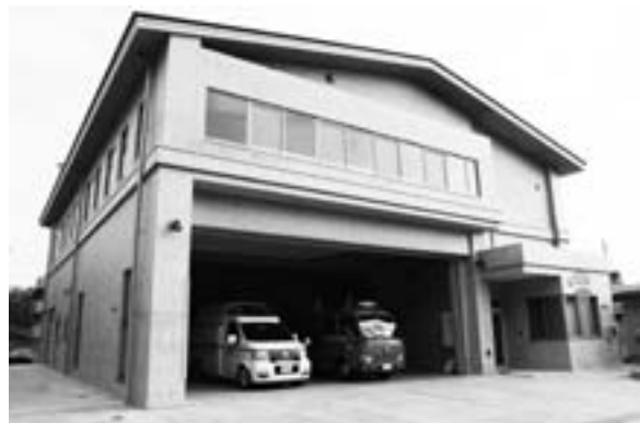
改築工事が完了した麻生消防署柿生出張所新庁舎
