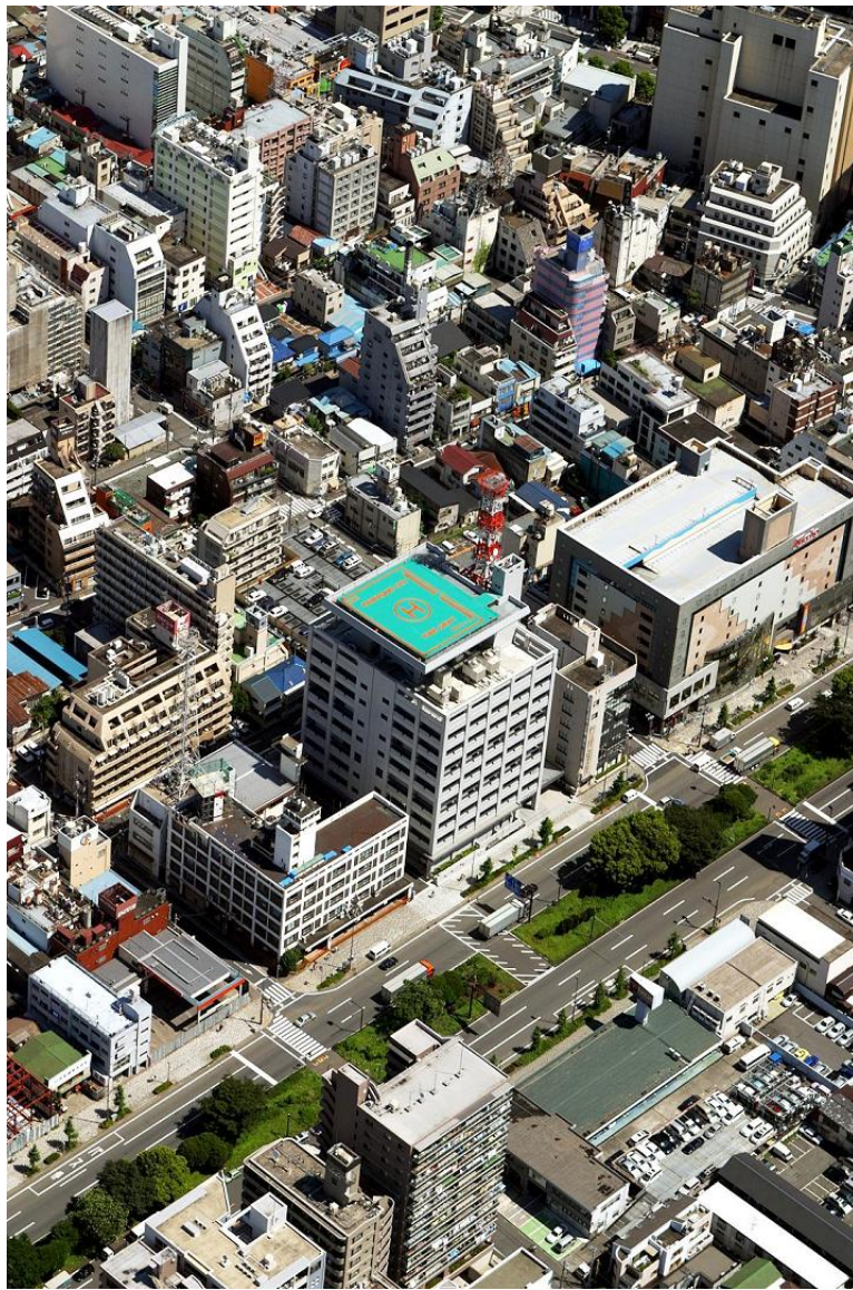
消防局総合庁舎
