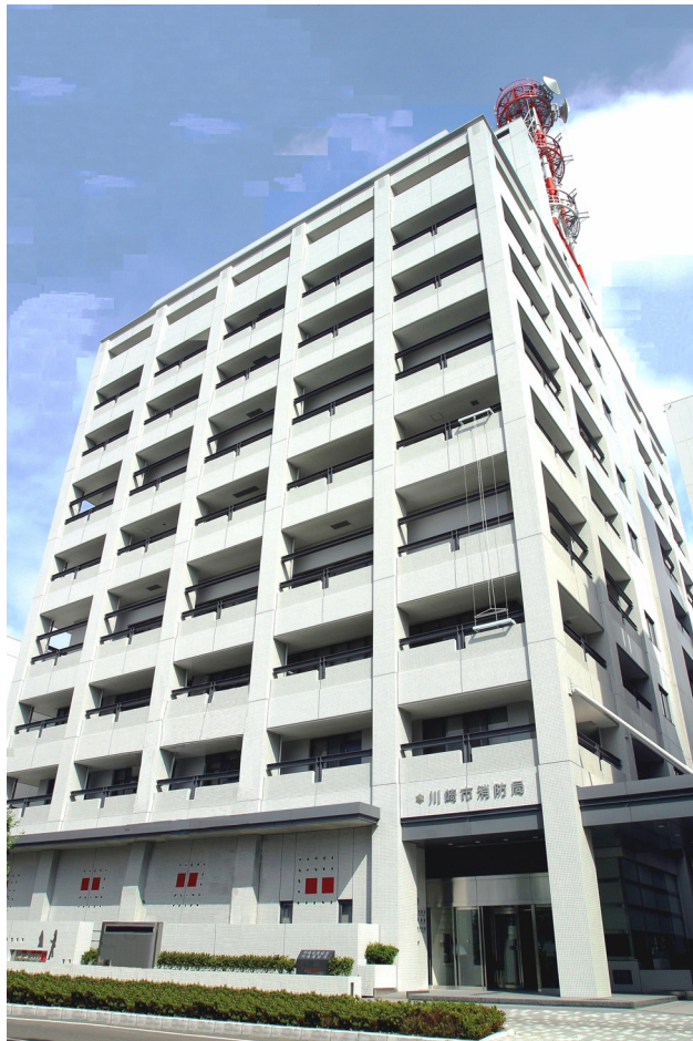
川崎市消防局総合庁舎
