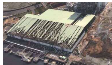
川崎区扇町燃料倉庫火災
