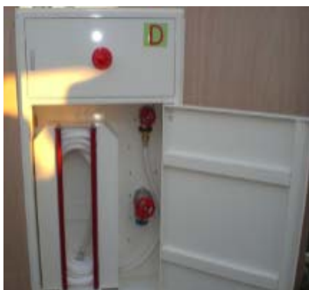
新規格の屋内消火栓設備
