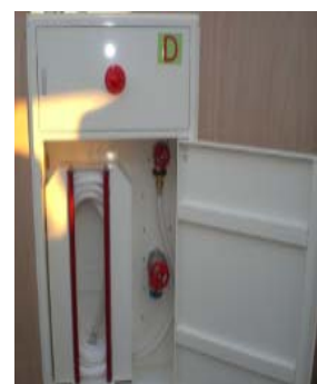
新規格の消火栓
