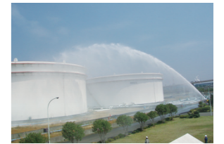
大容量泡放水砲 タンクの大きさに応じ、毎分数万リットル放水
