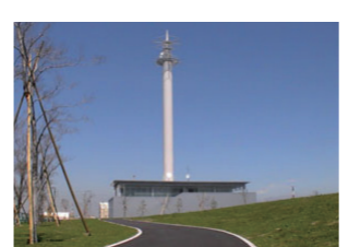
東扇島基幹的広域防災拠点 (政府(内閣府)) 機能：緊急物資輸送拠点
