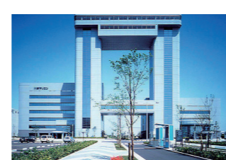
川崎市港湾振興会館 川崎マリエン 機能：津波避難施設
