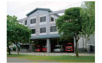
殿町消防出張所
