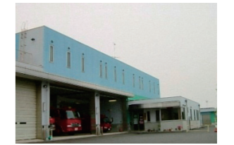
浮島消防出張所
