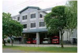
殿町消防出張所
