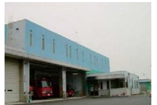
浮島消防出張所
