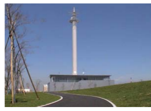
東扇島基幹的広域防災拠点 (政府(内閣府)) 機能：緊急物資輸送拠点
