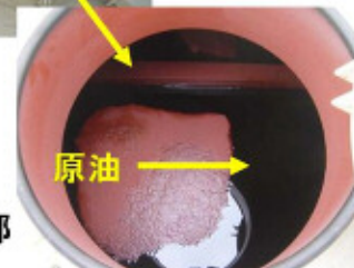
ポンツーン内への原油の滞油(3室 で破損有)スロッシング波高約1.9m
