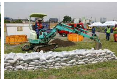
機動部隊による土止め
