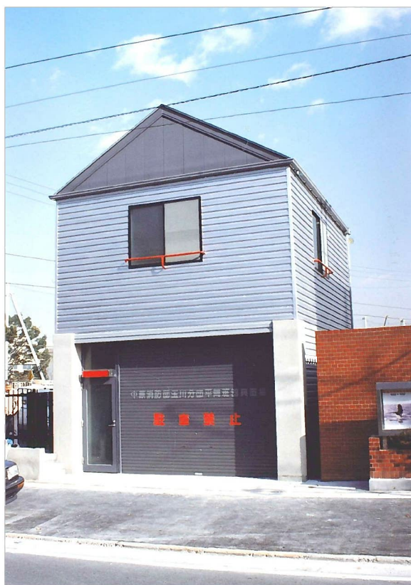
完成当時の平間班器具置場
