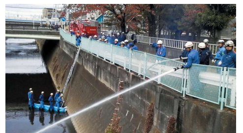
堰止めて揚水し放水
