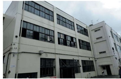
解体予定の校舎
