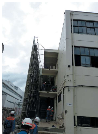
放水経路の階段
