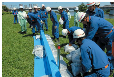
積土のう応用工法
