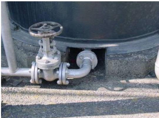
タンクの水抜管はタンクの側板に設けること。やむをえず底板に設ける場合は《危規則第21条4》に従う。
