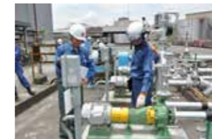
危険物施設の立入検査
