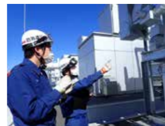
高圧ガス設備の立入検査
