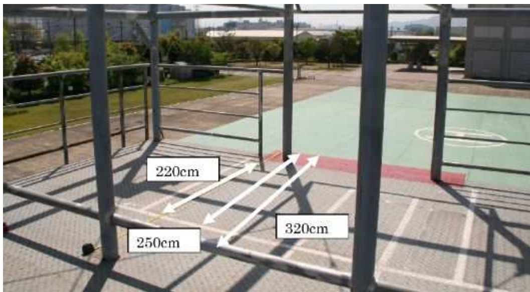
写真7 B・C塔 塔上
