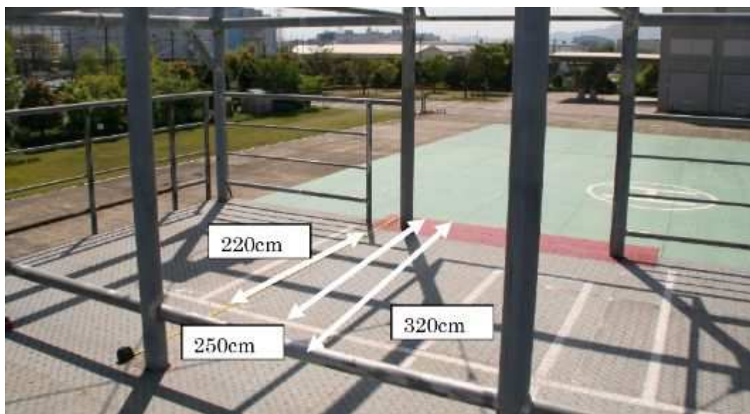
写真7 B・C塔 塔上
