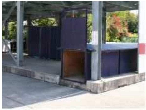
B塔 煙道入口
