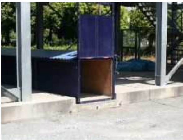
C塔 煙道出口
