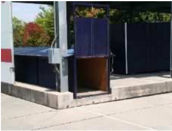
C塔 煙道入口
