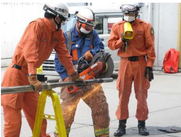
エンジンカッター取扱い (鋼材の切断)
