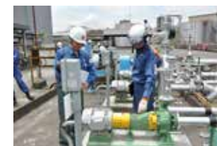
危険物施設の立入検査
