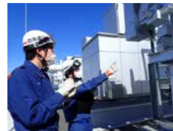
高圧ガス設備の立入検査
