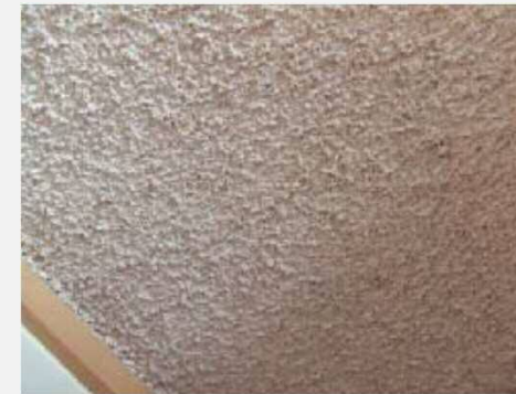
吹付けバーミキュライト (天井の断熱・吸音)
