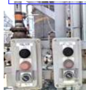
未使用アース線撤去
