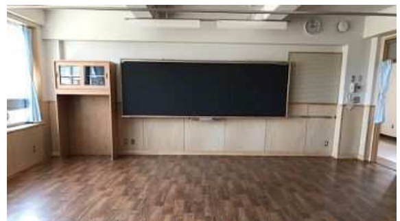
再生整備実施校：古川小学校（普通教室）
