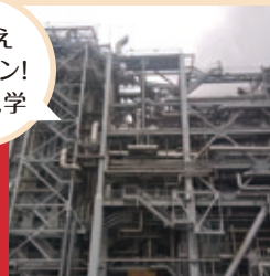
JERA川崎火力発電所
