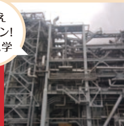
JERA川崎火力発電所
