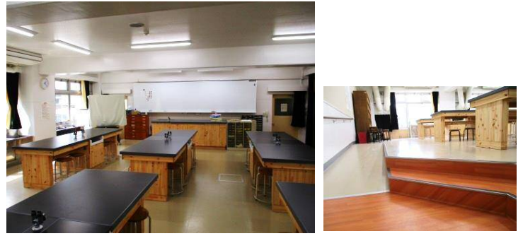
左) 老朽化した理科室の実験台を更新(西丸子小学校) 右) 実験台の更新に合わせて配管等の改修を行うため床を上げる(西丸子小学校)
