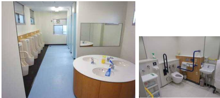
左)アイランドタイプの手洗いを設置した児童用トイレ(西丸子小学校) 右)周辺機器も含めて改修をした多目的トイレ(西丸子小学校)
