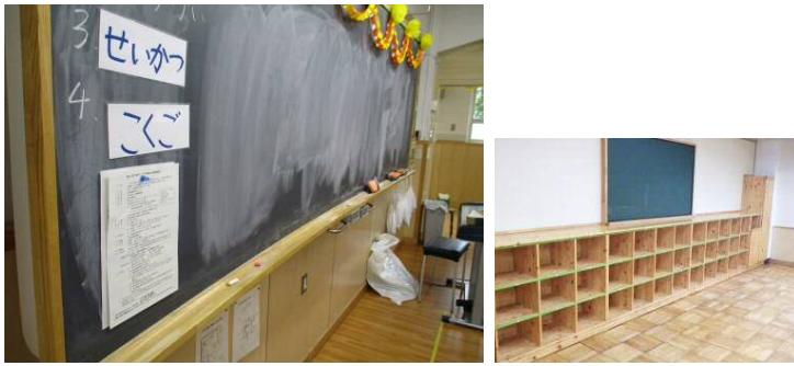
左) 新たに設置されたUD黒板(西丸子小学校) 右) 背面黒板や棚、掃除用具入れも更新(西丸子小学校)
