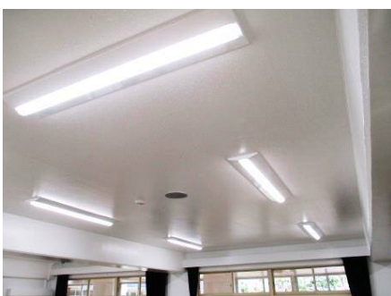
省エネルギー対策としてトイレや一部の特別教室に設置したLED照明(西丸子小学校)
