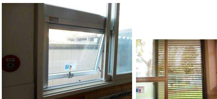
左)廊下に設置されたナイトパーズ用の倒し窓(久末小学校) 右)教室に設置されたナイトパーズ用のガラリ(西丸子小学校)
