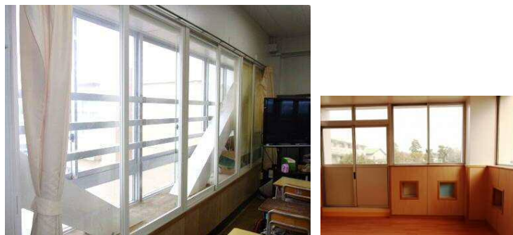
左)二重窓とロールスクリーンによる断熱(久末小学校) 右)断熱の効果を体感することができる小窓(西丸子小学校)
