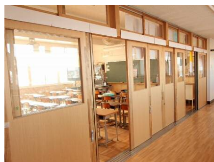
老朽化したパーテンションを更新し、明るい自然光が差し込む教室となる(久末小学校)
