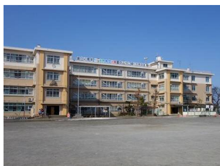
外壁全体を補修し塗装することで、長寿命化を図る(久末小学校)
