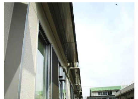
直射日光を遮り教室内の明るさのムラをなくし、夏の暑さを緩和できる庇(西丸子小学校)
