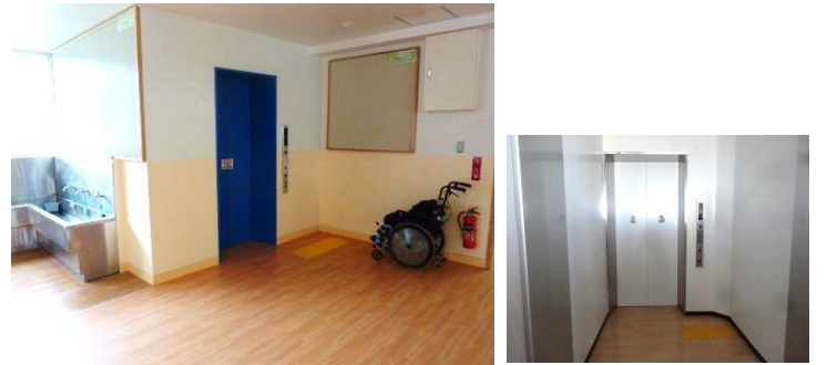
左) 水飲み場のあった場所に新たに設置したエレベーター(西丸子小学校) 右) 外増築により設置したエレベーター(久末小学校)
