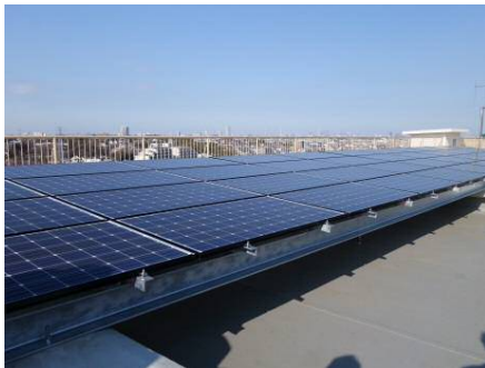
省エネルギーを図るとともに環境教育や災害時にも活用できる太陽光発電(久末小学校)
