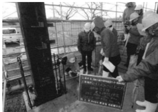
(鉄骨建方確認)
