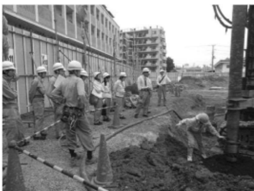
(杭工事施工確認)
