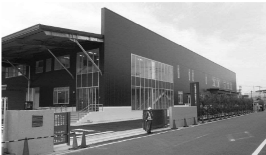
(南部学校給食センター施工状況 平成 29 年 5 月現在)
