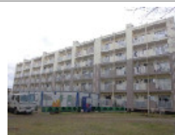
外壁改修：高山住宅
