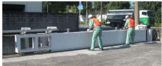
海岸保全施設の改良
