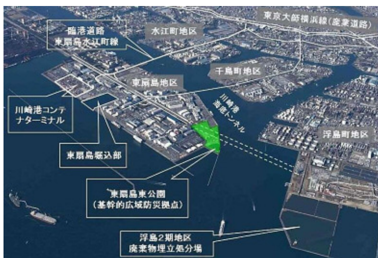
川崎港航空写真
