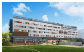
使用済プラスチック由来低炭素水素をエネルギー利用する水素ホテル (川崎キングスカイフロント東急REIホテル)
