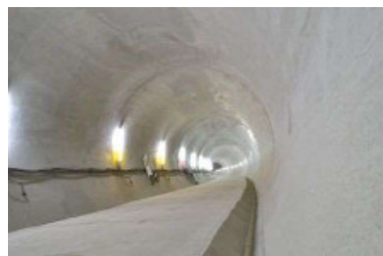
大師河原貯留管の整備
