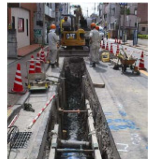
耐震管布設工事
