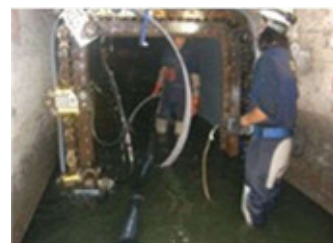
更生工法による再整備
