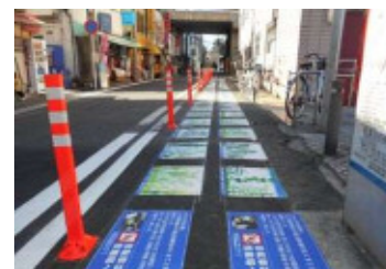
路面啓発シートの設置
