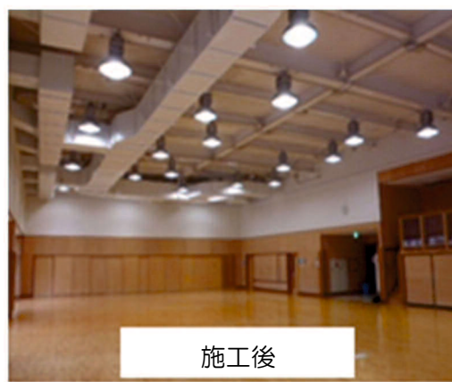
▲吊り天井の落下防止対策工事の施工前後の比較
