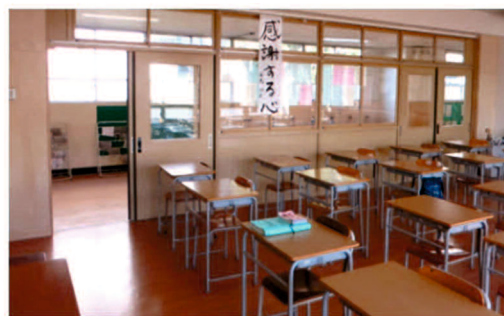
▲再生整備により改修された教室
