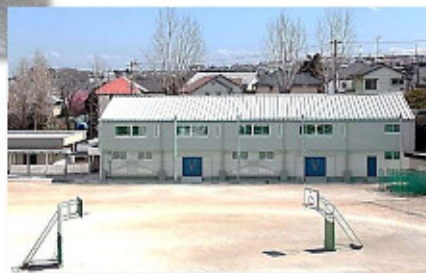
改修後の体育館
