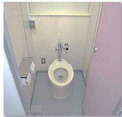
快適化された学校トイレ
