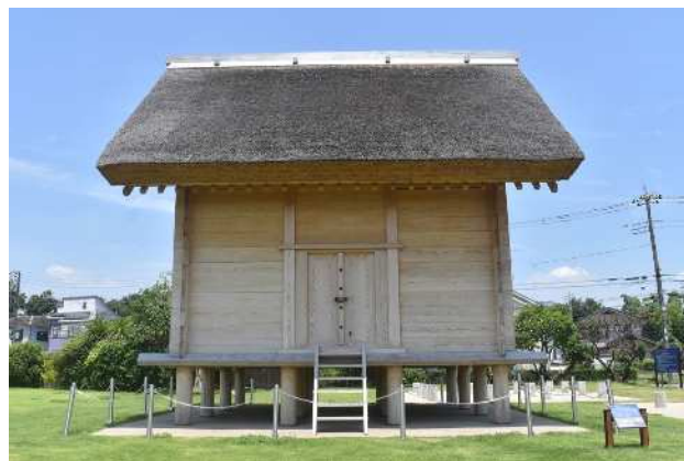
写真14 橘樹官衙遺跡群で遺構復元 （橘樹歴史公園の復元倉庫）
