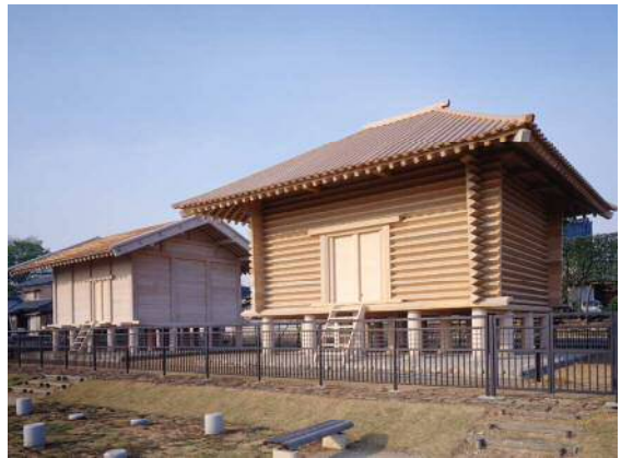
写真8 遺構復元の事例〔中宿遺跡（埼玉県深谷市）〕《写真は整備のイメージで、実際とは異なる場合があります》
