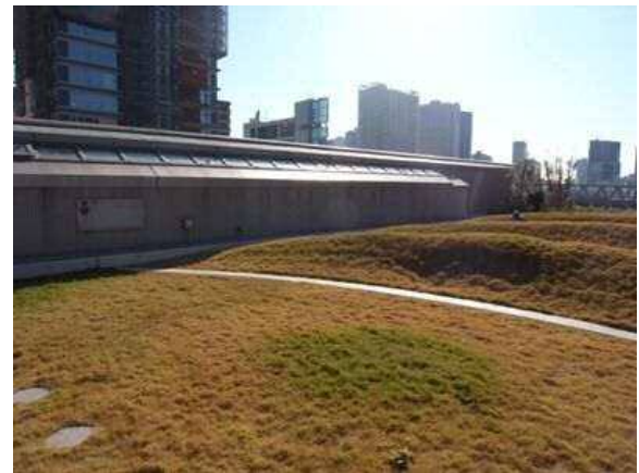
屋上面の芝生広場、全自動散水
