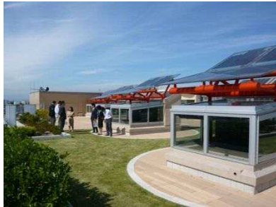
風の塔、スィンドウ、クールヒートトレンチによる暖冷房負荷の低減
