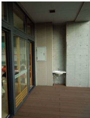
流しが設置されたバルコニー
