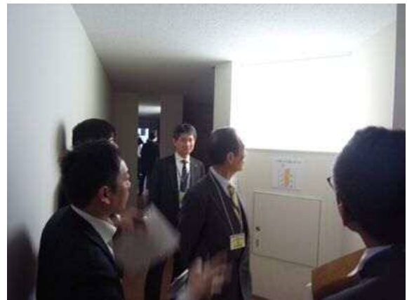
トイレ内の光ダクト
