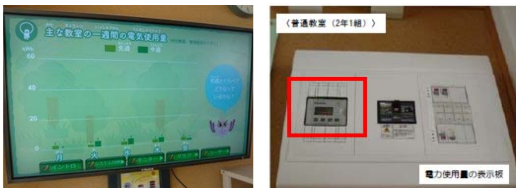
図2 普通教室単位での電力消費量の計測と「見える化」事例 (豊田市立土橋小学校)
