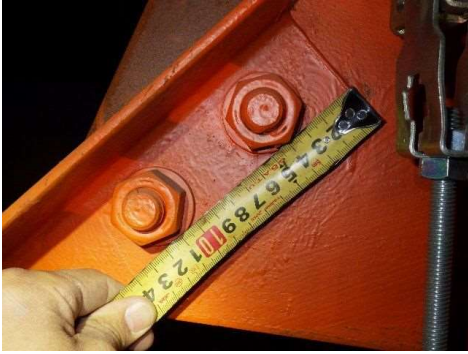
ホール客席天井裏接合部
