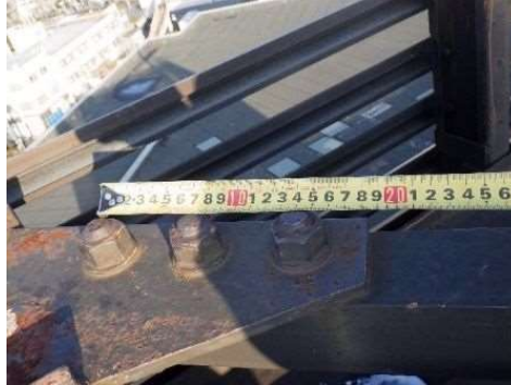
屋上排風機置場フェンス部材測定
