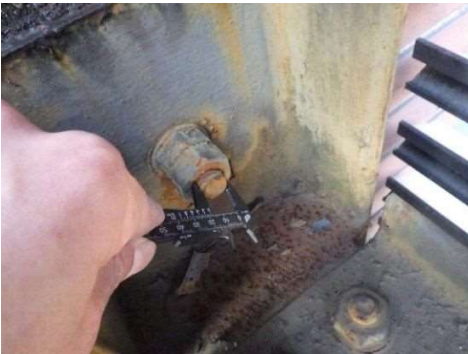
屋上排風機置場フェンス部材測定
