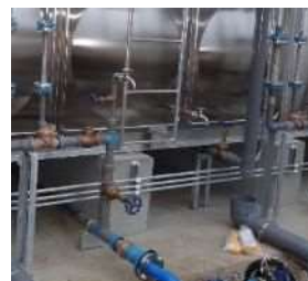
受水槽の給水栓
