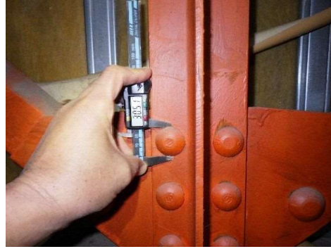
ホール客席天井裏部材測定
