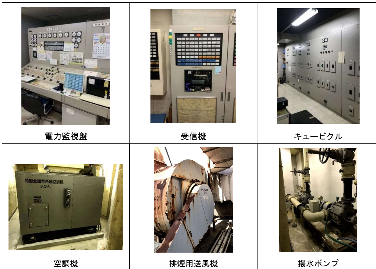
電気・機械設備の現況
