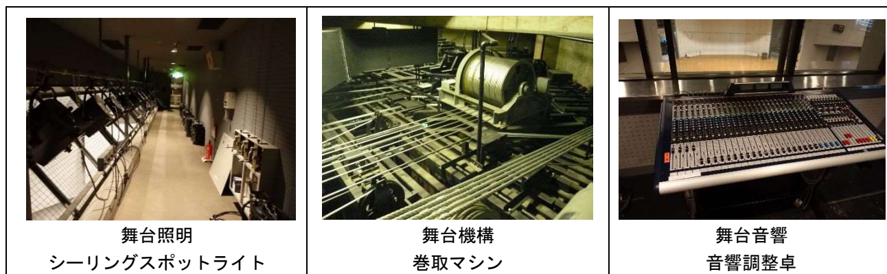
舞台設備の現況
